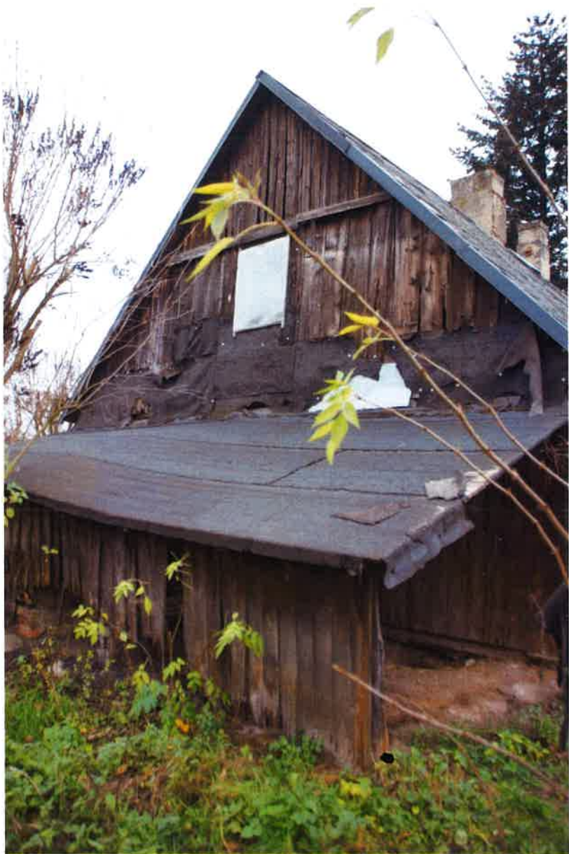
Fot. 4. Elewacja zachodnia
